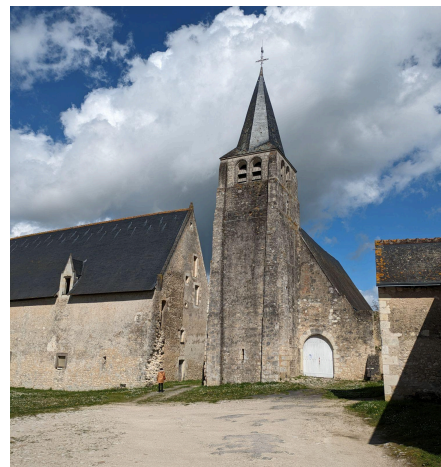
Eglise paroissiale Saint-Sulpice
