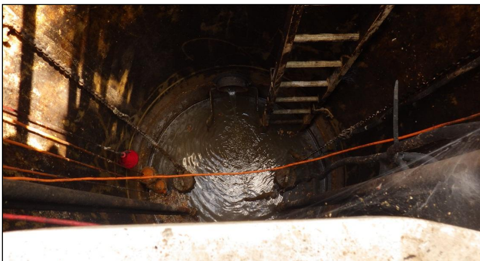
Photo 1 : PR rue du Moulin
